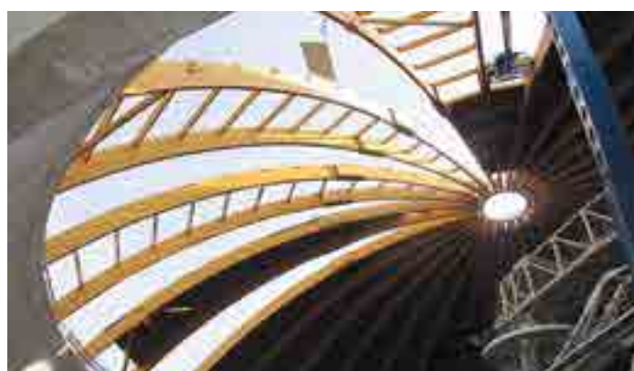
Konstrukcje z drewna klejonego stanowią element coraz większej ilości hal sportowych, hoteli, sal balowych, kościołów, hal produkcyjnych, magazynowych oraz obiektów rolniczych i wielu innych.
