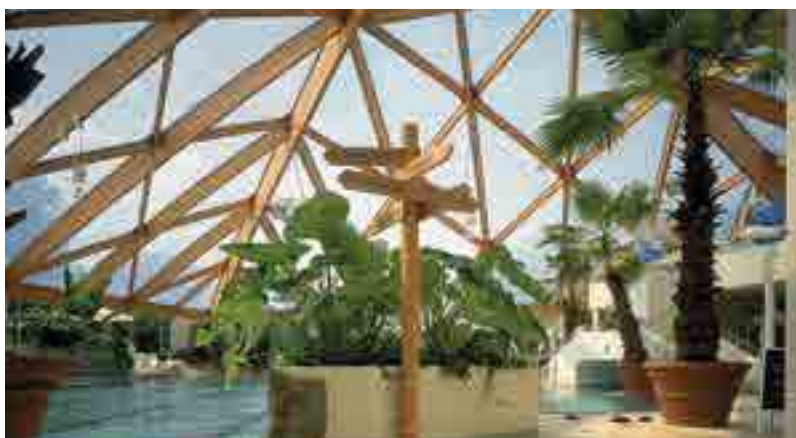
W przeciwieństwie do stali oraz żelbetu drewno jest materiałem naturalnym, co czyni je odpornym na działanie środowisk agresywnych. Dzięki temu znajduje szczególne zastosowanie przy budowie zadaszeń basenów, magazynów soli, nawozów.
