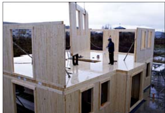
Fot. 4 | Budowa domu z elementów z drewna klejonego
