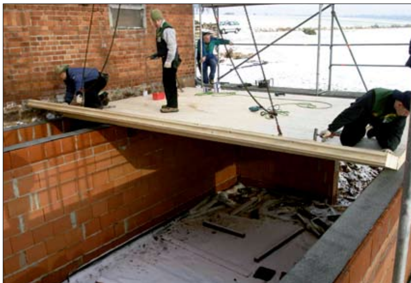
Fot. 1 | Montaż stropu
