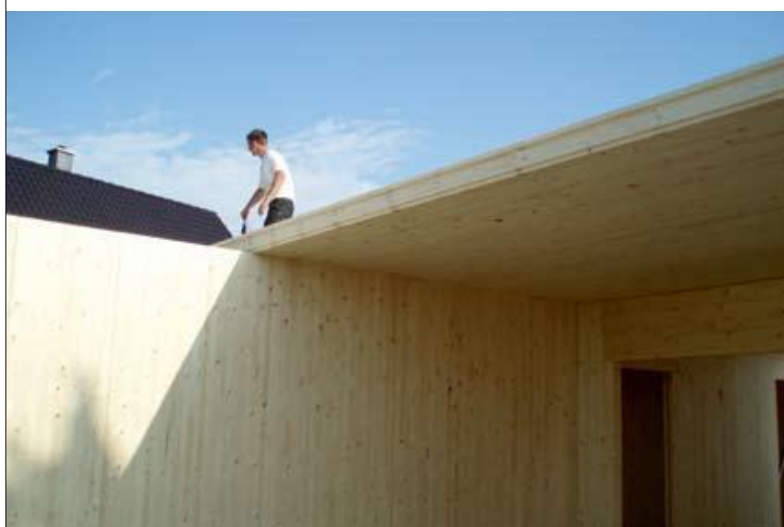
Fot. 4 | Montaż stropu
