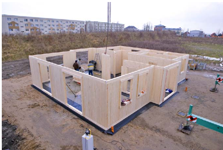
Fot. 1. Montaż prefabrykowanych ścian na placu budowy.
