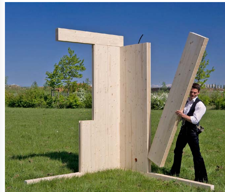
Fot. 2. Schemat montażu panel po panelu na placu budowy, niczym duże klocki "Lego".
