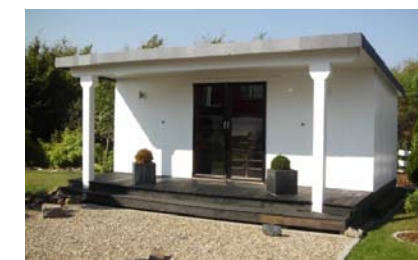
Fot. 6. Gotowa altana ogrodowa.
