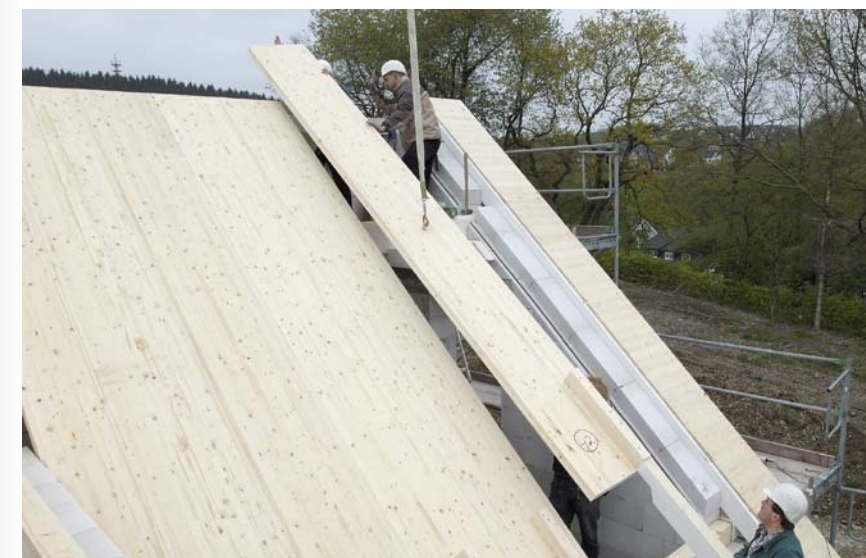
Fot. 3. Montaż paneli na budynku jednorodzinny.
