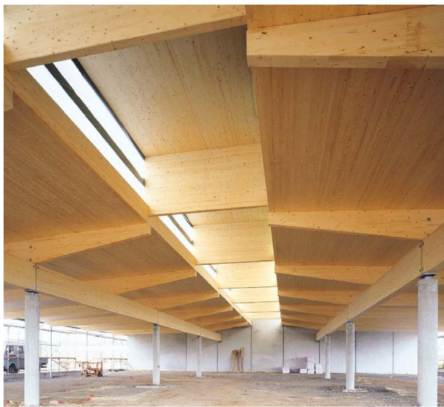
Fot. 1. Masywna konstrukcja dachu w obiekcie wielkopowierzchniowym.
