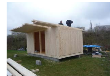
Fot. 5. Montaż stropodachu w altanie ogrodowej.
