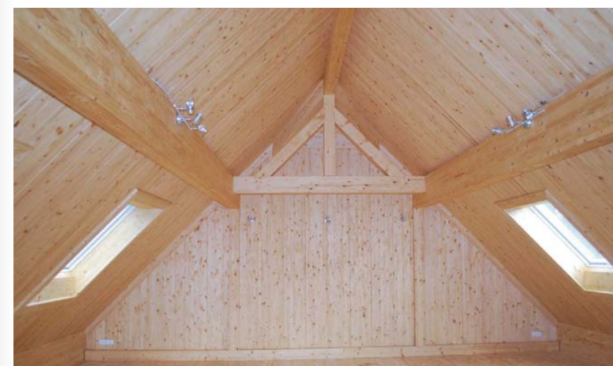
Fot. 4. Widok poddasza.
