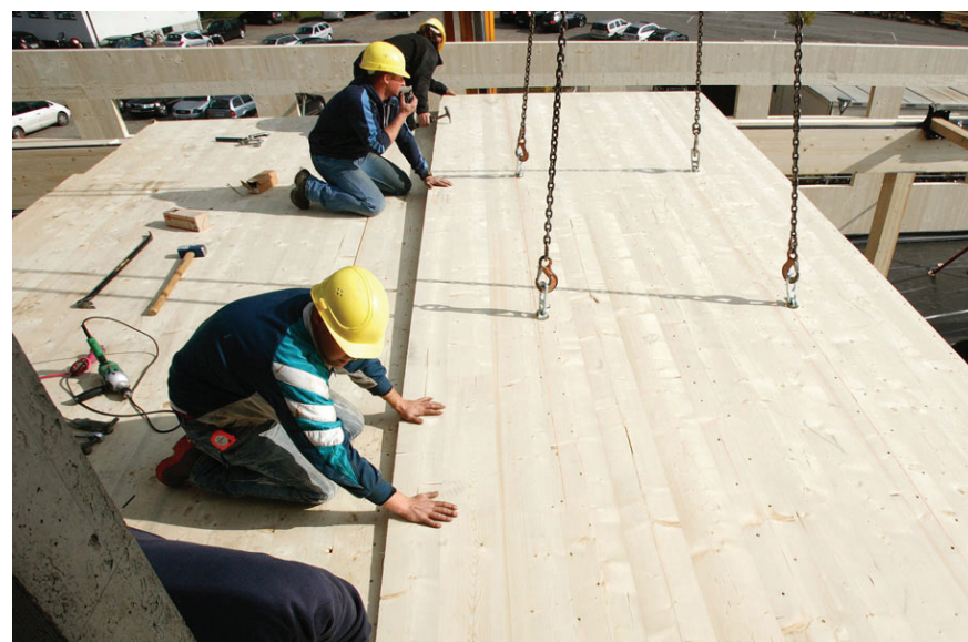
Wymiary to: grubość 6-40cm, szerokość 290-350cm długość 14 do 16,5m
