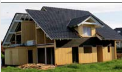
Fot. 7 | Początek budowy, montaż ścian, stropu i dachu (archiwum firmy Hüttemann)
