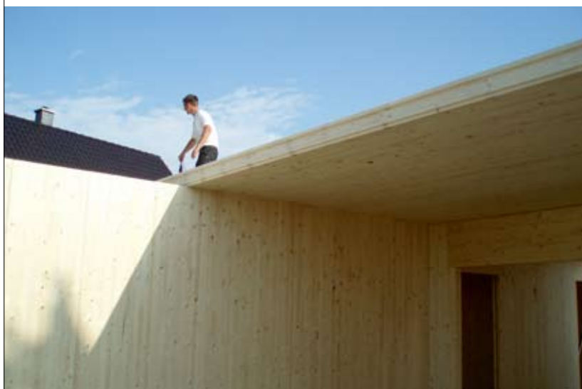
Fot. 4 | Montaż stropu
